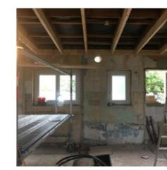
**Contre-chevrons support de l'isolation de la toiture par l'intérieur**
